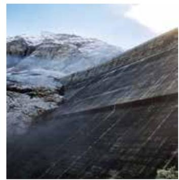
Pour ces barrages dont la stabilité est assurée par leur propre poids, le volume de béton est maximal si on le compare à la génération postérieure des barrages voûtes.
